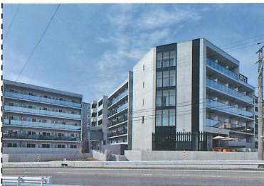
R5年2月完成・鉄筋5階・全190室・総合補償要・新潟市西区大学南1
