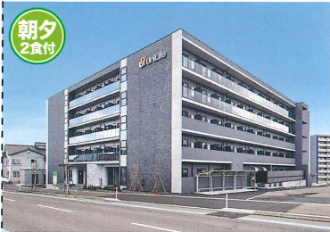
R4年2月完成・鉄筋5階・全188室・総合補償要・新潟市西区大学南1
